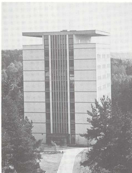
Schwesternwohnhaus Stadenstraße 56 (heute Mitarbeiterwohnhaus) 1966 fertiggestellt
