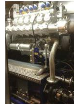
sehen lassen. Während ein modernes Kohlegroßkraftwerk auf einen Wirkungsgrad von maximal 45 Prozent kommt, erreicht das Blockheizkraftwerk beeindruckende 90 Prozent.
