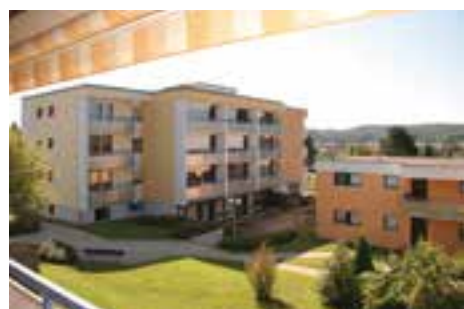
Seniorenwohnanlage Sonnenhalde des Seniorenzentrums Martha-Maria Wüstenrot.
