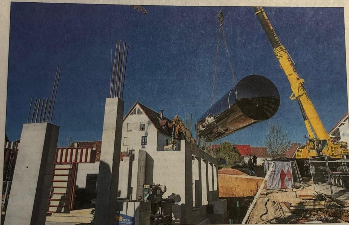
Der neue Löschwassertank wird im vorbereiteten Erdreich versenkt.
